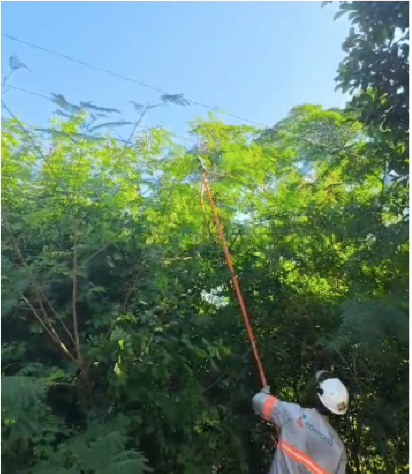
Figura 5: Corte com Mini Motosserra
